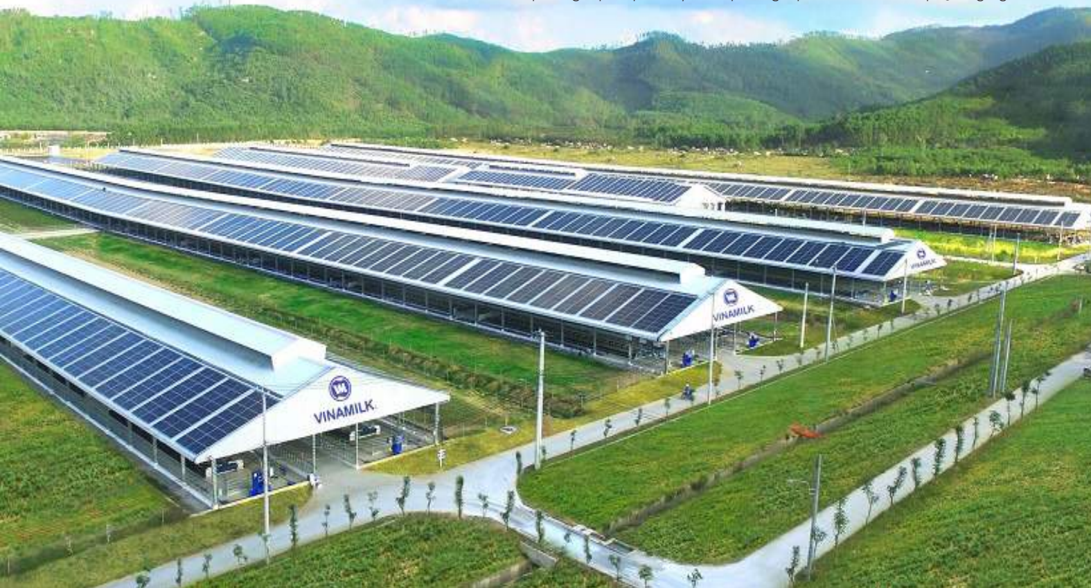
Hệ thống điện mặt trời áp mái tại trang trại bò sữa Vinamilk tại Quảng Ngãi.
